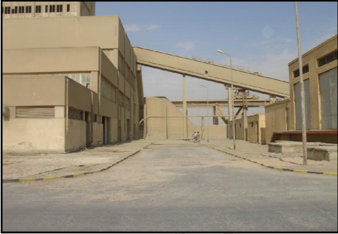
صورة رقم (١) توضح تناثر دقائق الغبار داخل المعمل
