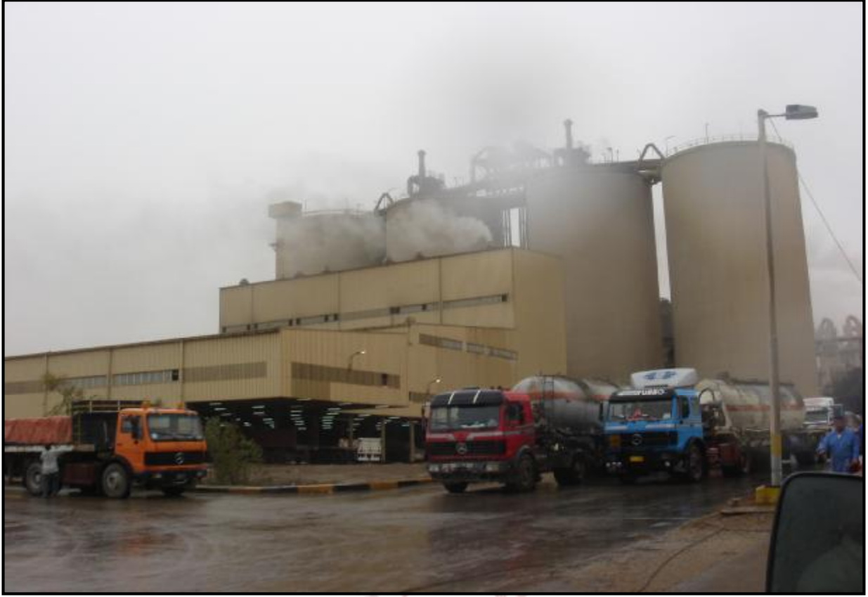
صورة توضح سايبلوات الاسمنت ووحدة التعبئة وطرح الملوثات بسبب توقف المرسبات الميكانيكية في هذه الوحدات
